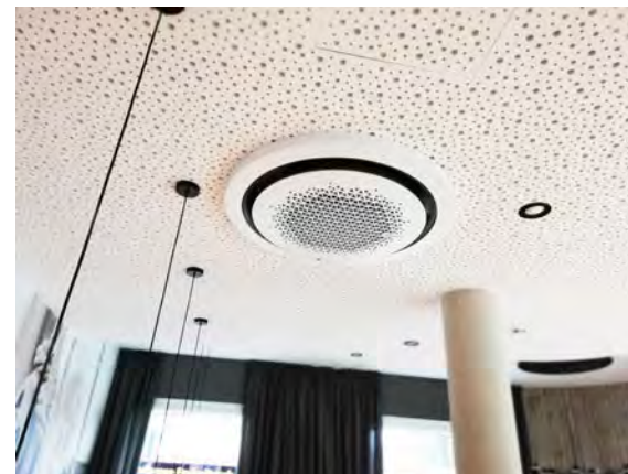
Fotos der installierten Wind-Free™ 360° Round Airflow Deckenkassetten
