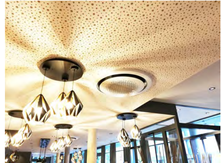
Fotos der installierten Wind-Free™ 360° Round Airflow Deckenkassetten
