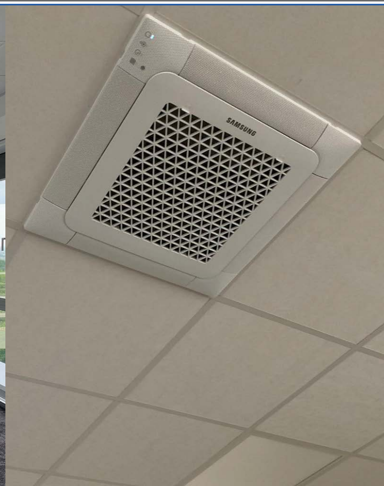
Foto der installierten Wind-Free™ Mini Deckenkassette 620x620
