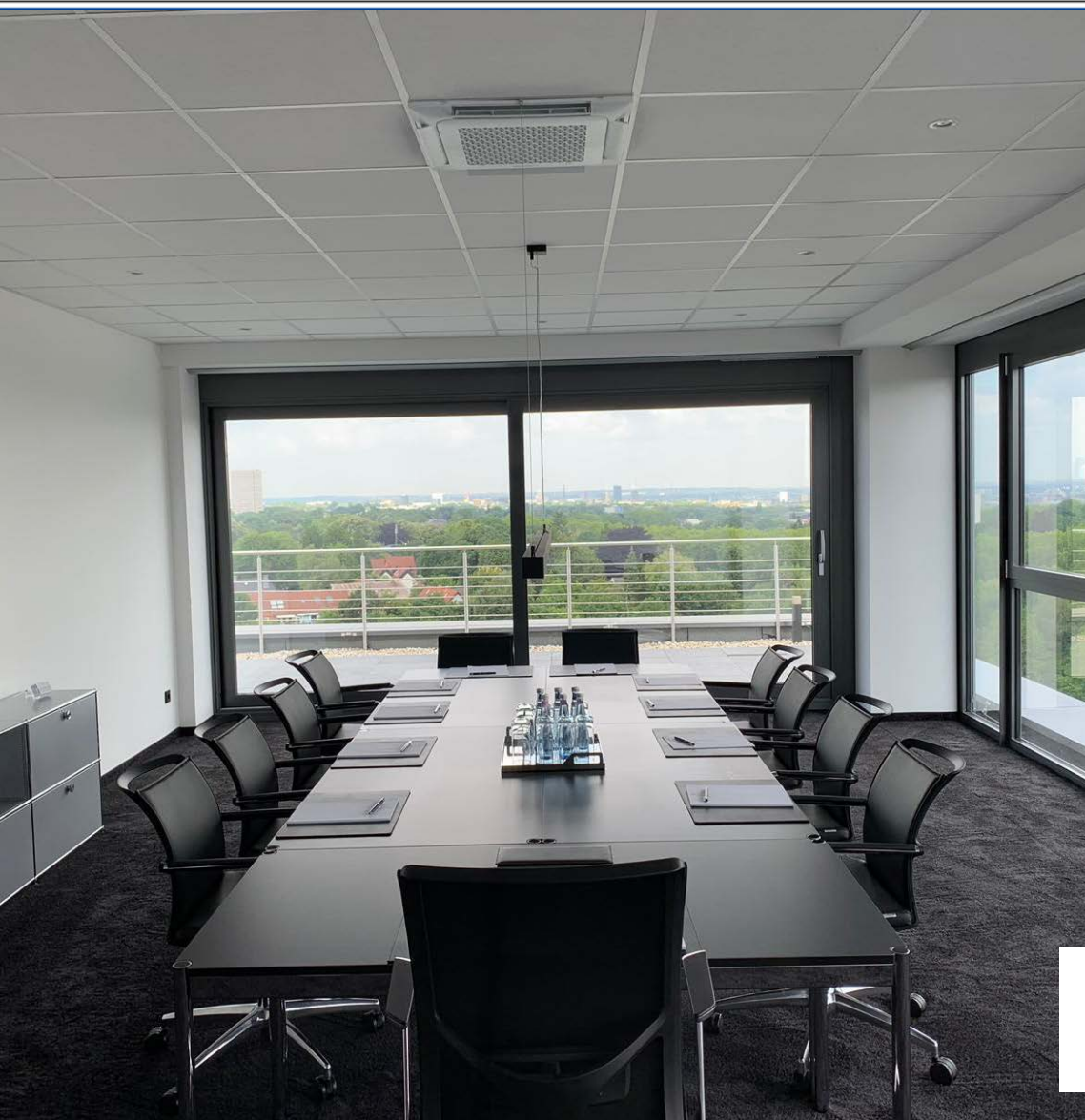
Foto der installierten Wind-Free™ Mini Deckenkassette 620x620
