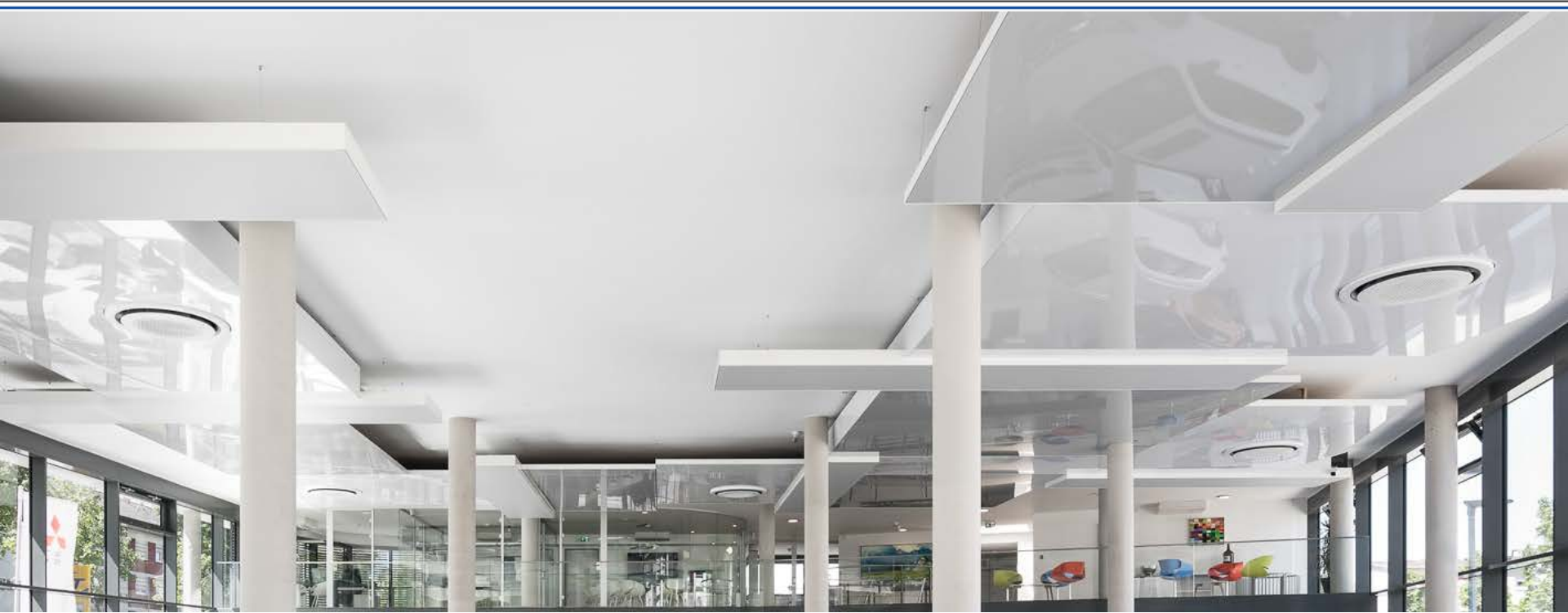
Fotos der installierten Wind-Free™ 360° Round Airflow Deckenkassetten
